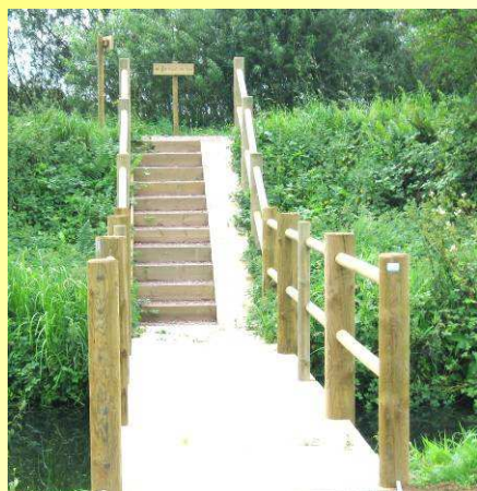
Passerelle menant à la voie verte
